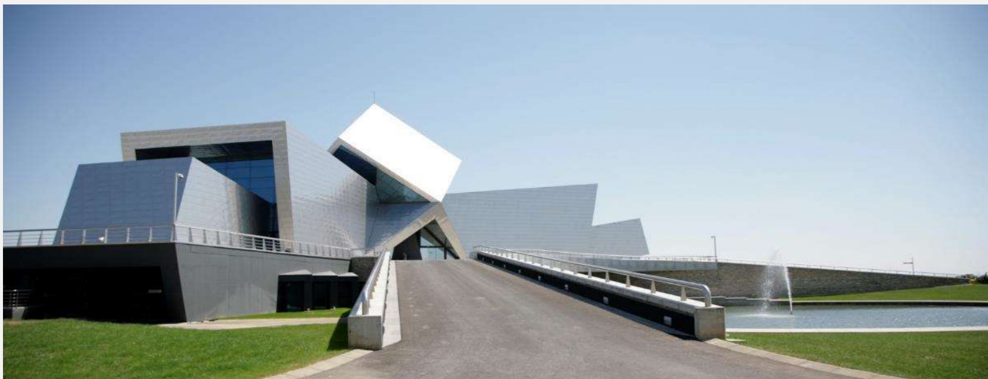
BODEGA IRIUS Barbastro, Huesca - Espagne / Marino Pascual & Asociados Arquitectura © Adriana Landaluce / Executed using Aperam 316L Uginox Top finish
