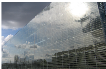
Archives Départementales du Bas-Rhin, Strasbourg - Francja. Architekt: Bernard Ropa & TOA Podwójna powierzchnia szkło / stal nierdzewna Wykonano z Uginox Méca 8 ND 304 / 1.4301 (polerowane na lustro) © Bernard Ropa
