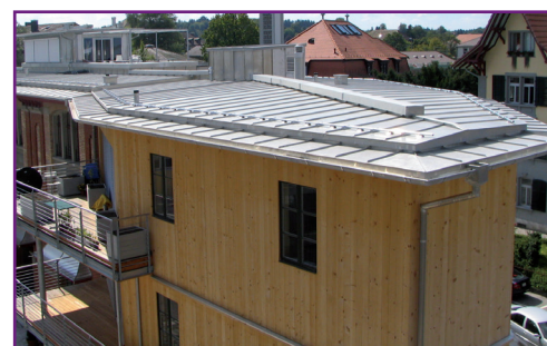
Alte Kohlenhandlung, Langenthal - Suisse. Architectes : Blum & Rossenbacher Réalisé avec la nuance K41 d'aspect UGINOX Patina
