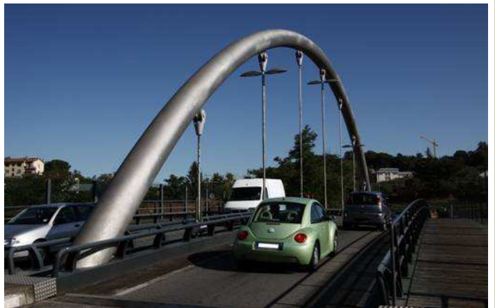
Arco Ponte Malizia - Siena in 2304
